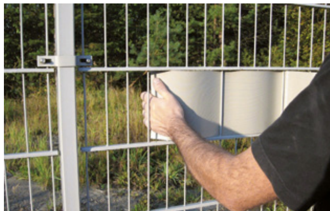
Montaż taśmy ogrodzeniowej
